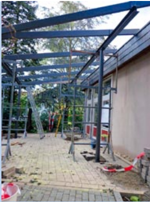
Das Glasdach der Terrasse im Bau
